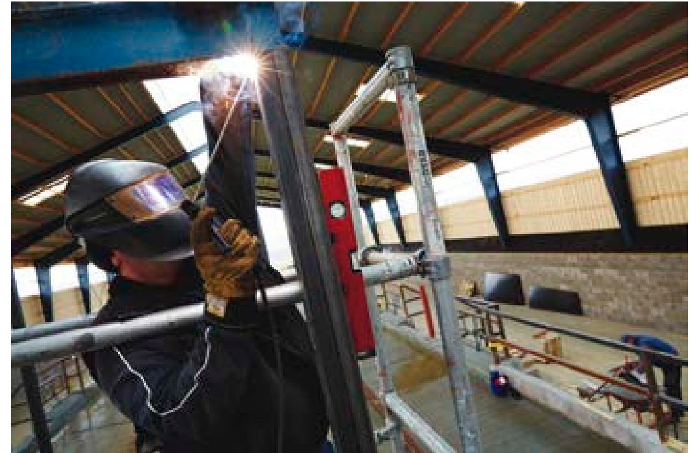
Grzegorz Bertosiewicz och hans team bygger en ny ladugård. Därefter ska de bygga en ännu större. Wapnö växer så att det knakar.
